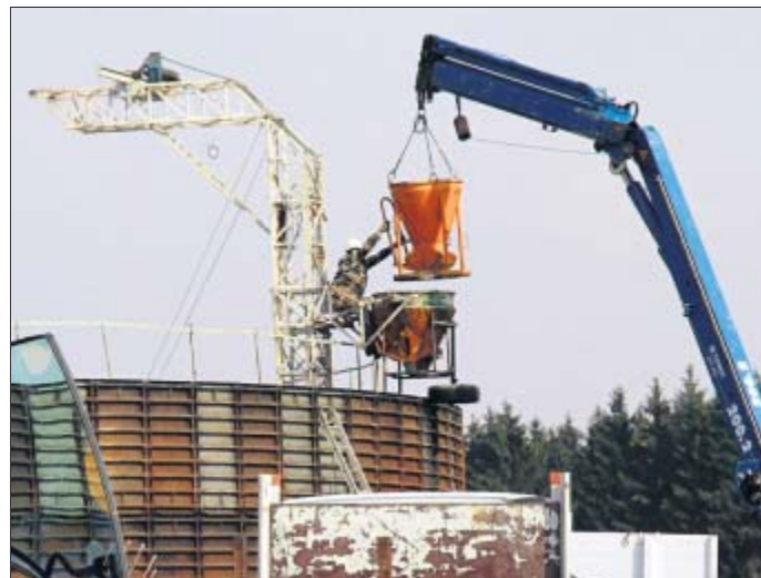
Aus Beton gegossen werden der Nachgärer und das Endlager der neuen Anlage – das Kraftwerk wird im Sommer geliefert.
