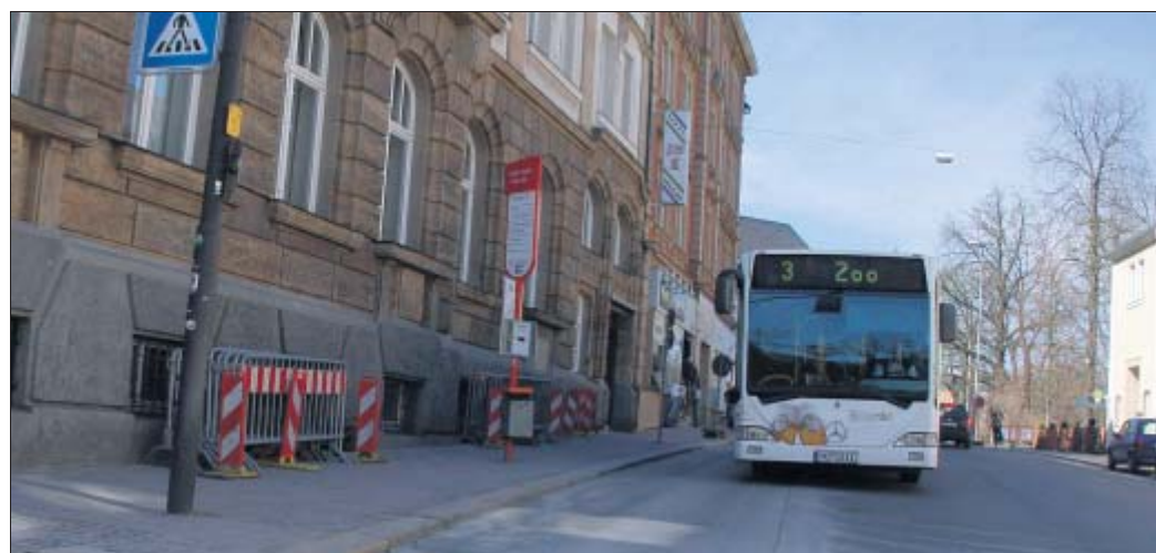
Auf einer Länge von etwa 45 Metern wird die Busbucht in einer Tiefe von bis zu 1,50 Metern in die Poststraße hineingebaut. Der Asphalt ist bereits vorgeschritten.
